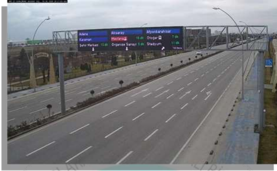
Görsel 3 Konya'da ISSD firması tarafından geliştirilen Bluetooth okuyucular ile tespit edilen seyahat süresinin gösterimi [5]
